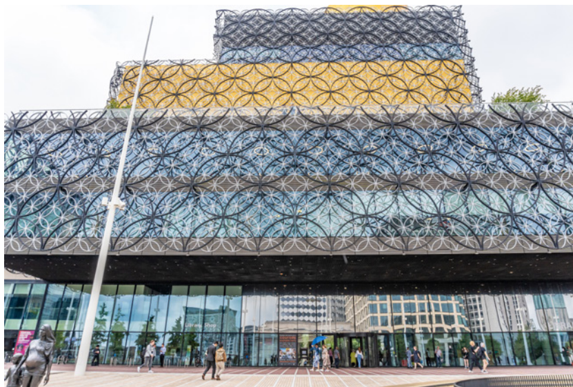
Biblioteca di Birmingham, Regno Unito.
