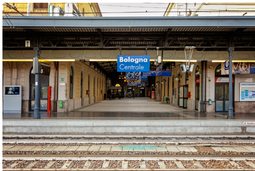
Stazione Centrale di Bologna.
